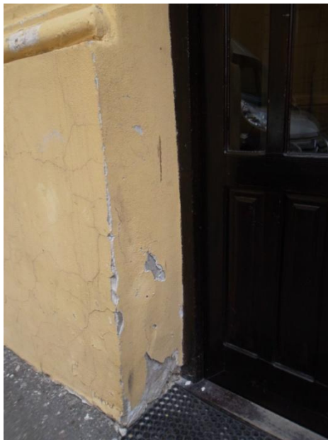
Obrázok 25 Vstup do školy z bočnej strany – opadávanie omietky (Zdroj: Vlastné spracovanie)
